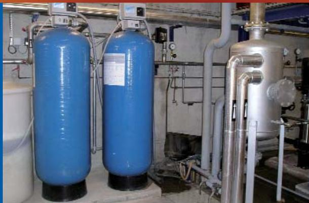
Babcock Wanson a développé une gamme complète d'adoucisseurs standards série ACS de 25 à 550 litres de résines, idéale pour des chaudières de faibles et moyennes puissances jusqu'à 25 t/h de vapeur.
