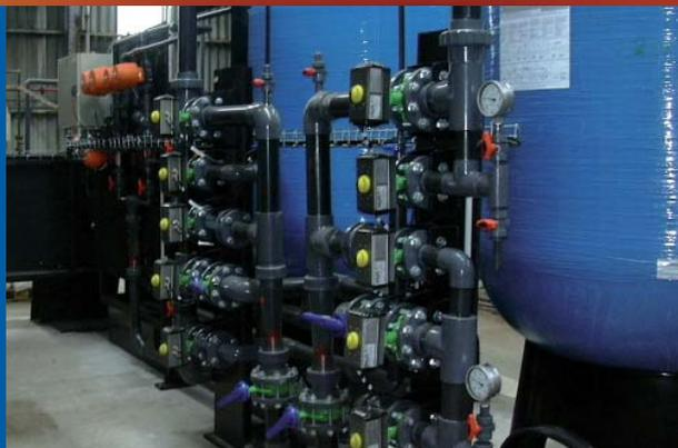
**La décarbonation ou déminéralisation partielle permet d'éliminer les carbonates et bicarbonates (TAC) en utilisant des résines cationiques faibles régénérées à l'acide.**
